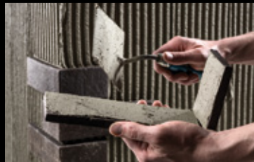
Die Eckwinkel werden im Floating-Buttering-Verfahren verarbeitet.
