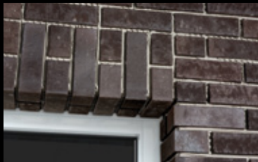
Ein perfekt mit Winkeln nachgebildeter Fenstersturz.
