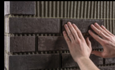
Das Setzen der Flächen-Klinkerriemchen mithilfe einer Schnur. Die Klinkerriemchen werden in das Klebbett eingedrückt.
