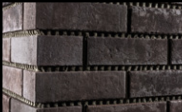
Die fertig verlegte Fläche. Nach Standzeit kann mit dem Ausfugen begonnen werden.
