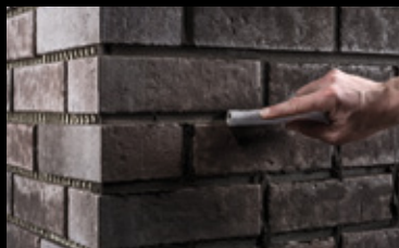
Mit der Kellenverfugung können verschiedene Optiken herausgearbeitet werden.
