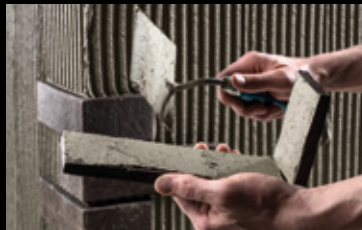
Die Eckwinkel werden im Floating-Buttering-Verfahren verarbeitet.
